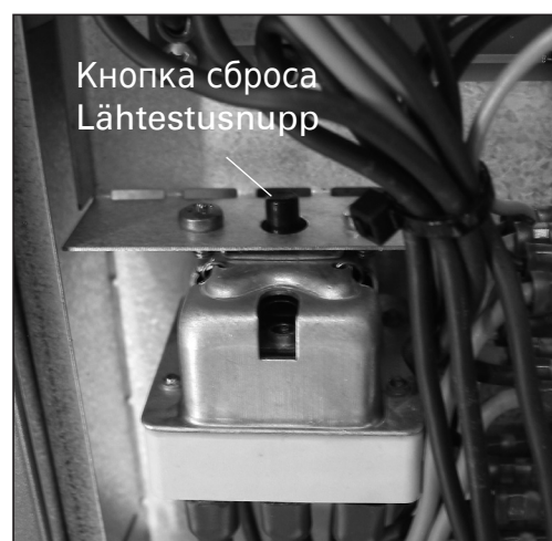
Рис. 3. Защита от перегрева Joonis 3. Ülekuumenemiskaitse
