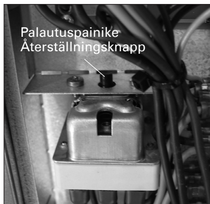
Kuva 3. Ylikuumenemissuoja Bild 3. Överhettningsskydd
